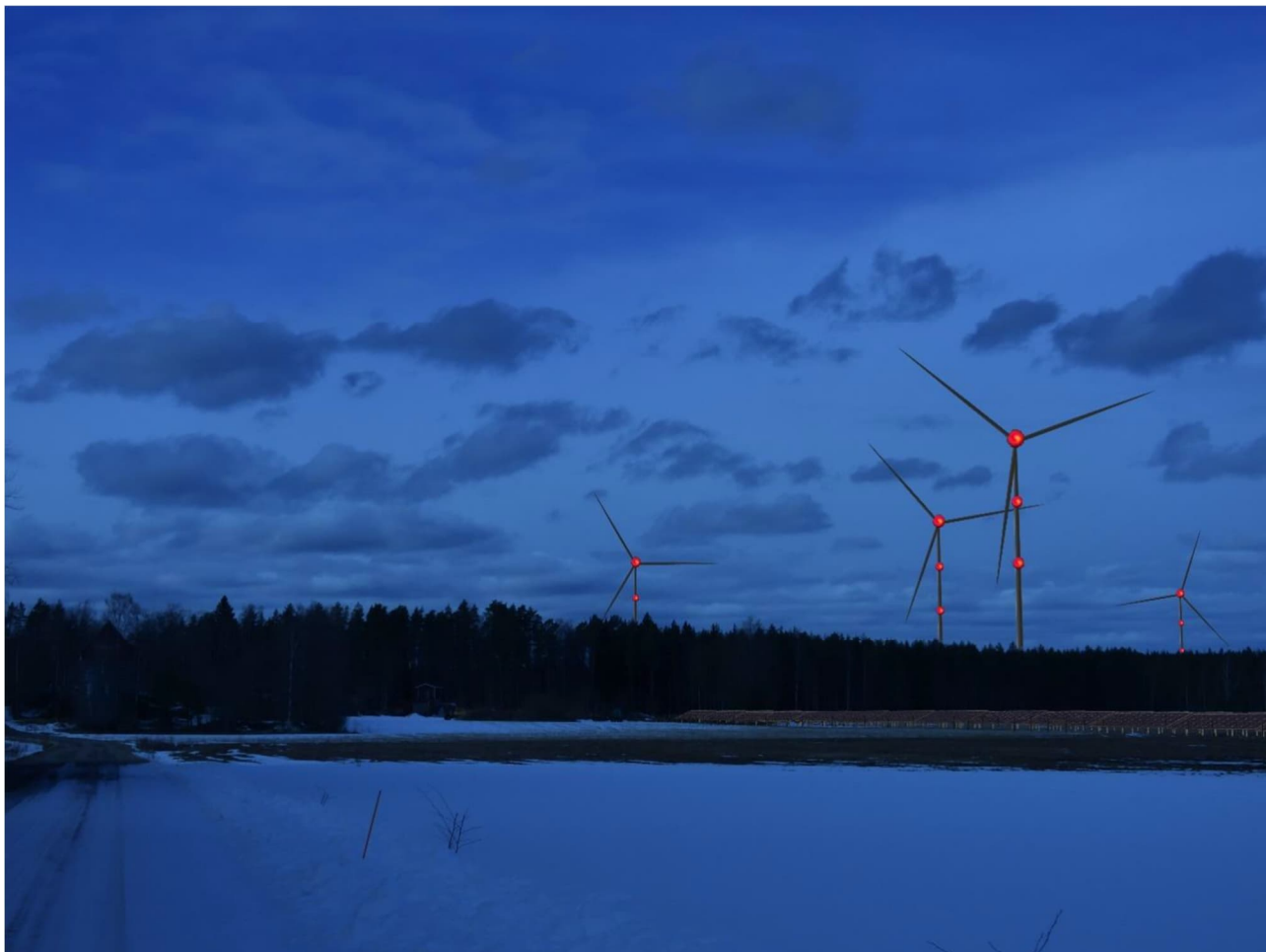
Kuva 23. Kuvaspaikka 6. Näkymä tuuli- ja aurinkovoimaloille päin pimeällä.
