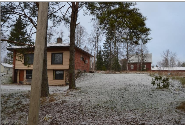
Kuva 11. Ylikoskenkadun molemmin puolin on muodostunut pienehkö, tyyllisesti kerroksellinen omakotialue 1960–1980-luvuilla. Kuva on otettu Ylikoskenkadulta pohjoiseen, oikeassa reunassa näkyy Ylikosken tilan rakennuksia.
