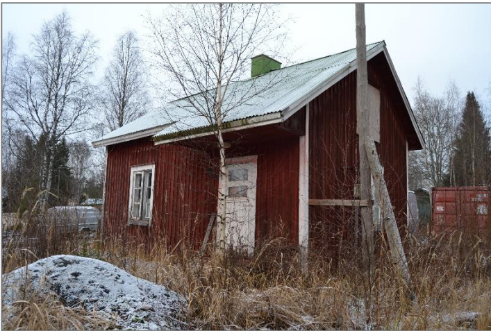
Kuva 20. Rakennuksen itäpääty ja eteläsivu.
