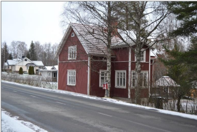
Kuva 24. Asuinrakennuksen eteläsivulla on kaksikerroksinen kuisti.
