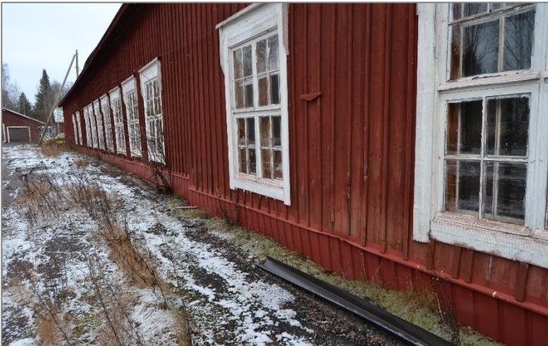
Kuva 16. Rakennuksen julkisivuihin on lisätty maanrajaan profiilipeltikuori. Kuva rakennuksen länsisivulta.
