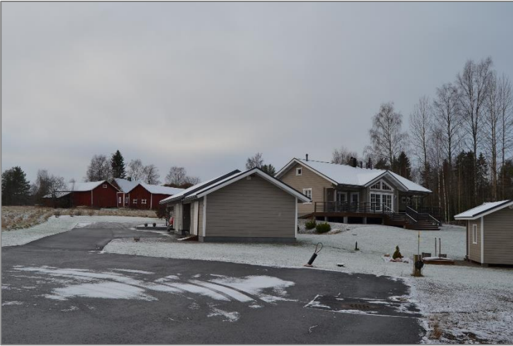
Kuva 10. Kairolammen rannan omakotiasutusta 2000-luvun alusta. Kuvan vasemmassa reunassa näkyy Ylikosken tilan rakennusryhmä 1900-luvun alkupuolelta.
