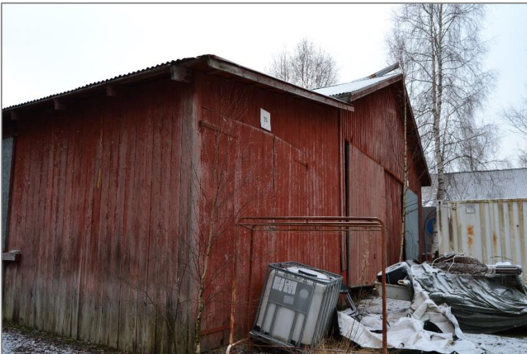
Kuva 18. Varastorakennuksen pohjoispäätä ja itäsivua.
