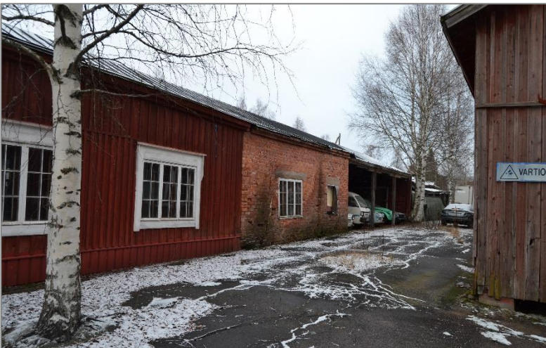
Kuva 17. Rakennuksen itäisivulla erottuu tiilirakenteinen osa.
