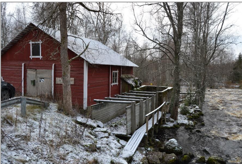
Kuva 7. Kairokosken mylly sijaitsee välittömästi selvitysalueen rajalla, kosken etelärannalla. Vuodelta 1929 oleva mylly on hirsirunkoinen, hakanurkkainen, pieni rakennus, jonka perustuksena on betonimuuri. Myllyn yhteydessä aiemmin sijainnut rankorakenteinen sirkkelikatot on purettu. Sahaus ja myllytoiminta Kairokosken myllyllä päättyivät 1980-luvulla.
